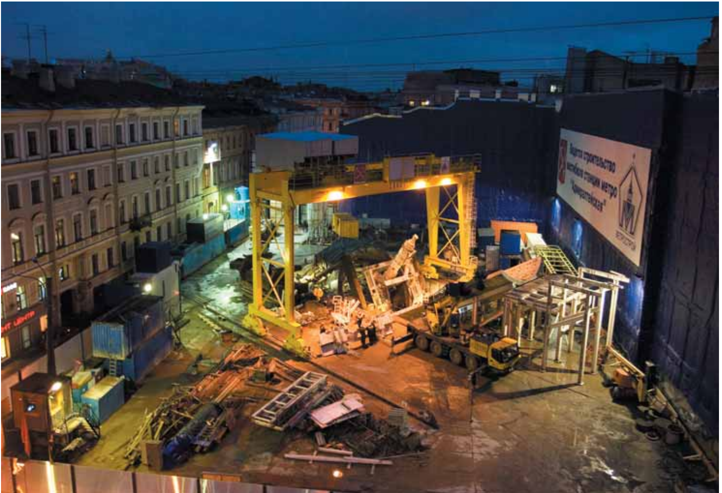
Монтаж ТПМК на станции «Адмиралтейская»
