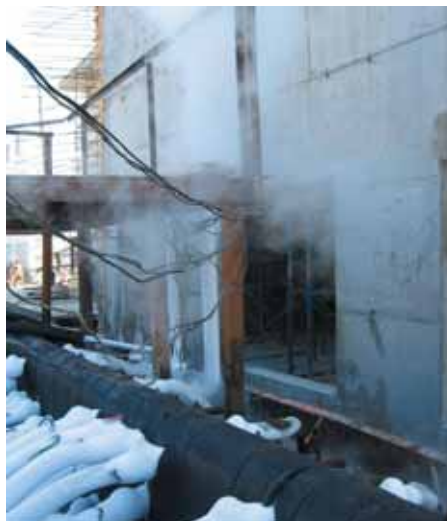
Рис. 2. Азотное замораживание грунтоцементного массива
