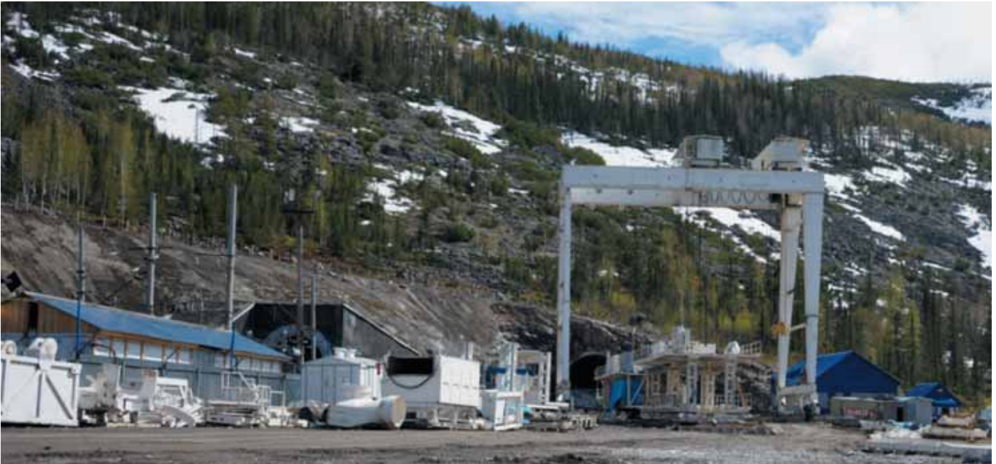
Рис. 3. Монтаж тоннелепроходческого механизированного комплекса
