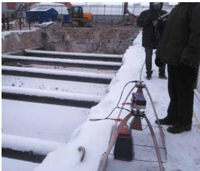
ЭМИ СШП исследования сплошности «стены в грунте» по периметру котлована
