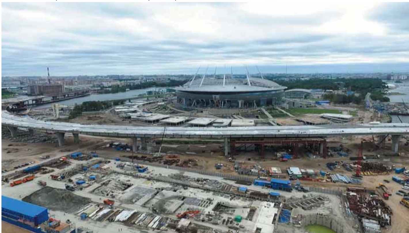
Рис. 1. Общий вид строительной площадки станции метро «Новокрестовская»
