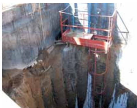
Рис. 4. Проходка шахтного ствола
