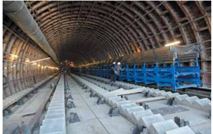
Монтаж эскалаторов, ст. «Проспект Славы»
