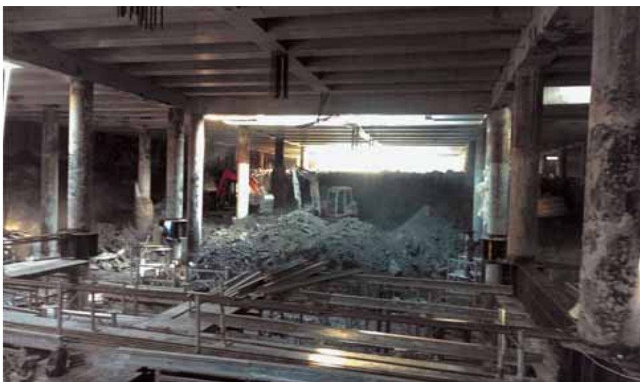
Рис. 10. Возведение перекрытия второго яруса ст. «Новокрестовская»
