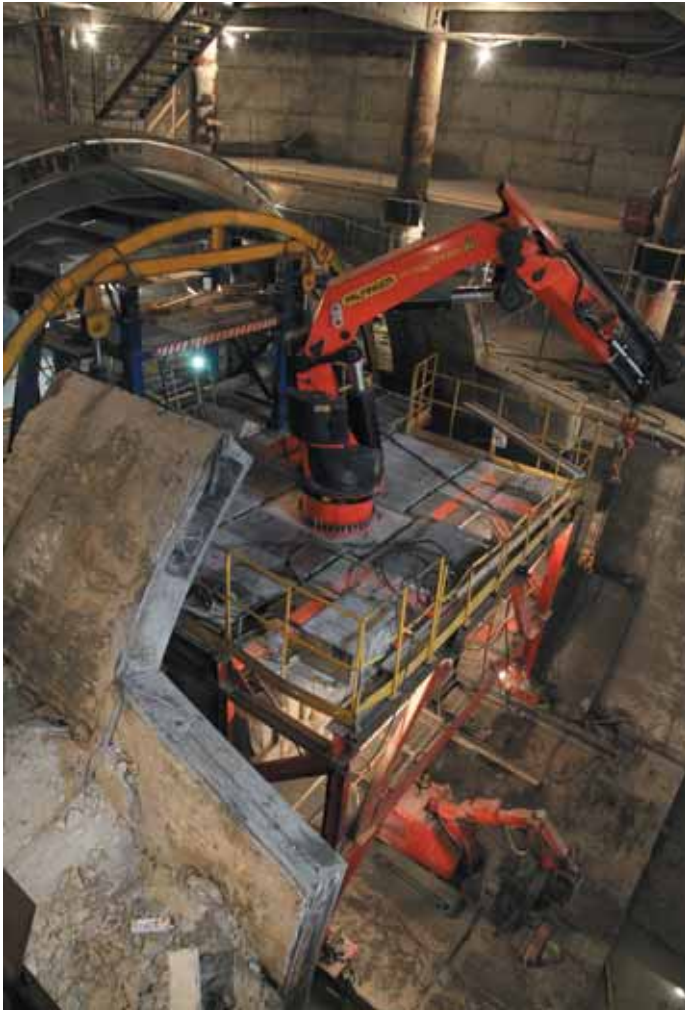
Демонтаж обделки в теле станции «Дунайский проспект»
