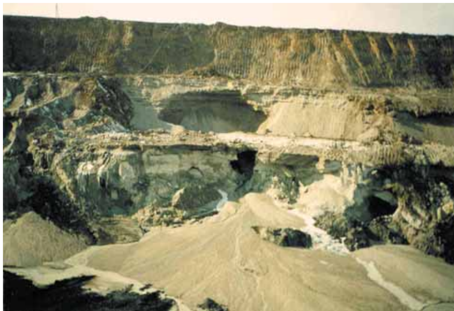
Рис. 2. Проявление суффозионных процессов на борту карьера
