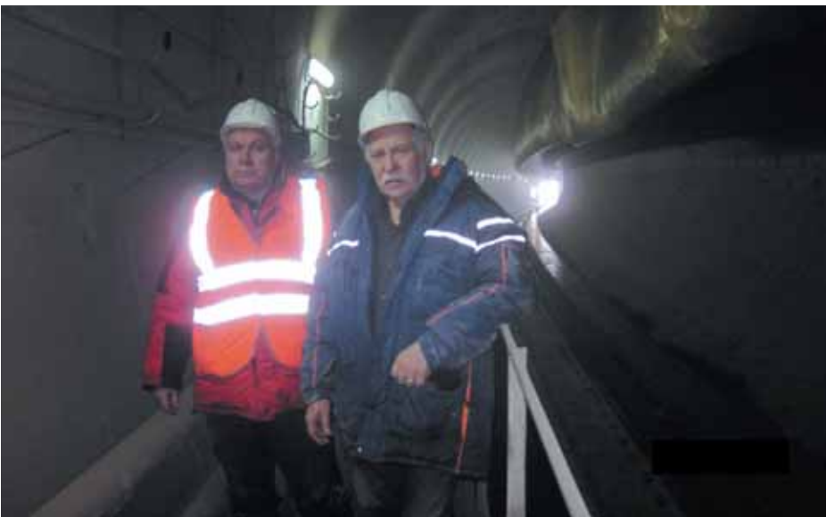
Рис. 4. Строительство нового Байкальского тоннеля
