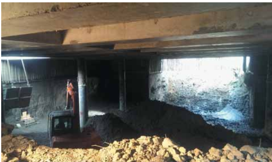
Рис. 9. Отрывка грунта под перекрытие второго яруса ст. «Новокрестовская»
