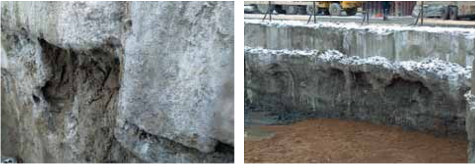
Рис. 2. Локальные участки некачественного заполнения бетоном (Санкт-Петербург, обследование «стены в грунте» на ст. «Беговая»)
