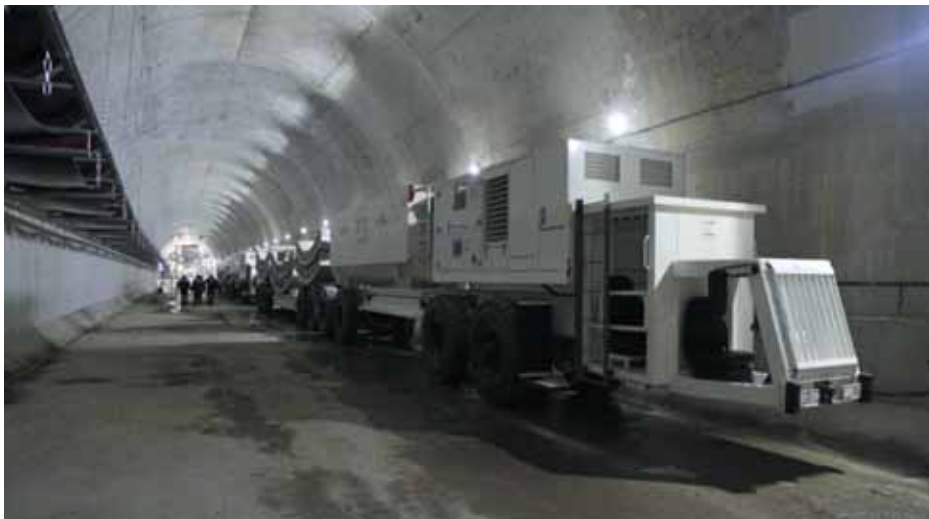
Рис. 12. Строительство двухпутного тоннеля мелкого заложения от «Южной» до ст. «Проспект Славы»
