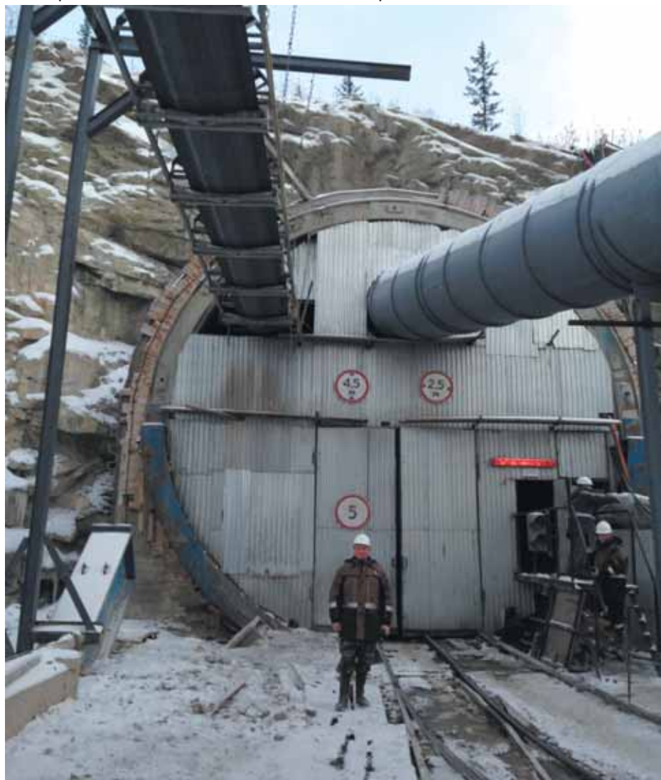
Рис. 2. Врезка нового Байкальского тоннеля. Западный портал
