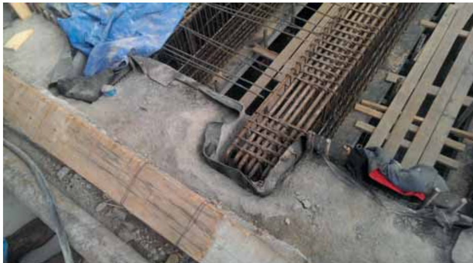
Рис. 7. Опираие балок покрытия на «стену в грунте»
