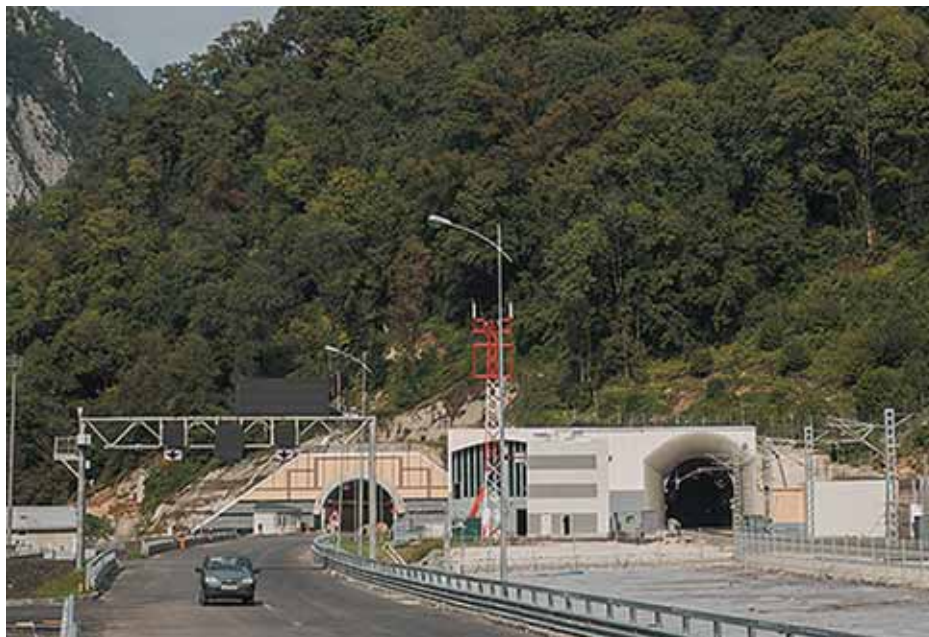
Рис. 5. Тоннельный комплекс № 1 совмещенной дороги Адлер – «Альпика-Сервис»
